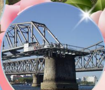
สะพานขาดตานตง
