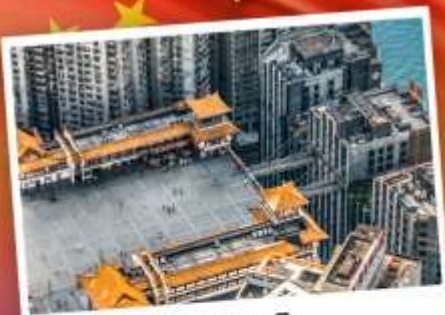
อาคารยูนีซิง
